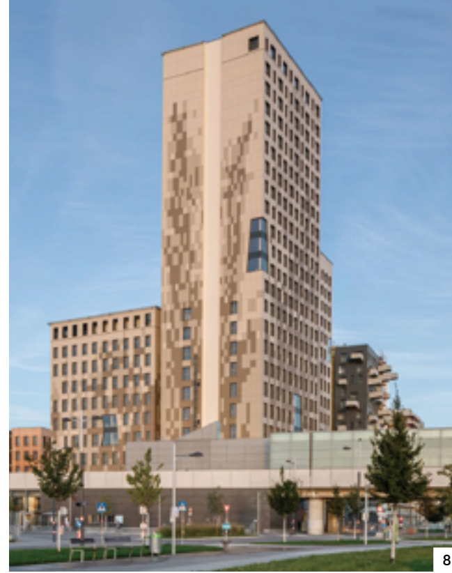
8,9,10 오스트리아 HoHo Wiwn 아파트와 호텔. 23층 높이의 콘크리트+목재 하이브리드 건물이다.(사진출처: SIGA 홈페이지)
