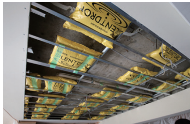
<그림 5> 천장속 공간 흡음재 설치 모습(일본 SILENT DROP, Catalogue)
