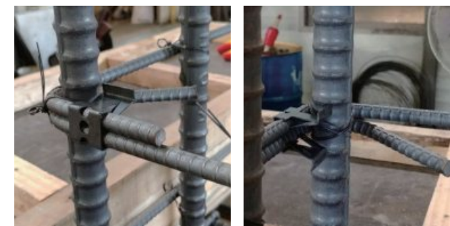
&lt;그림 6&gt; 체결 클립이 설치된 사례
