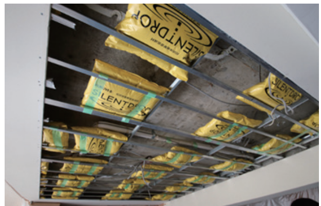
<그림 5> 천장속 공간 흡음재 설치 모습(일본 SILENT DROP, Catalogue)
