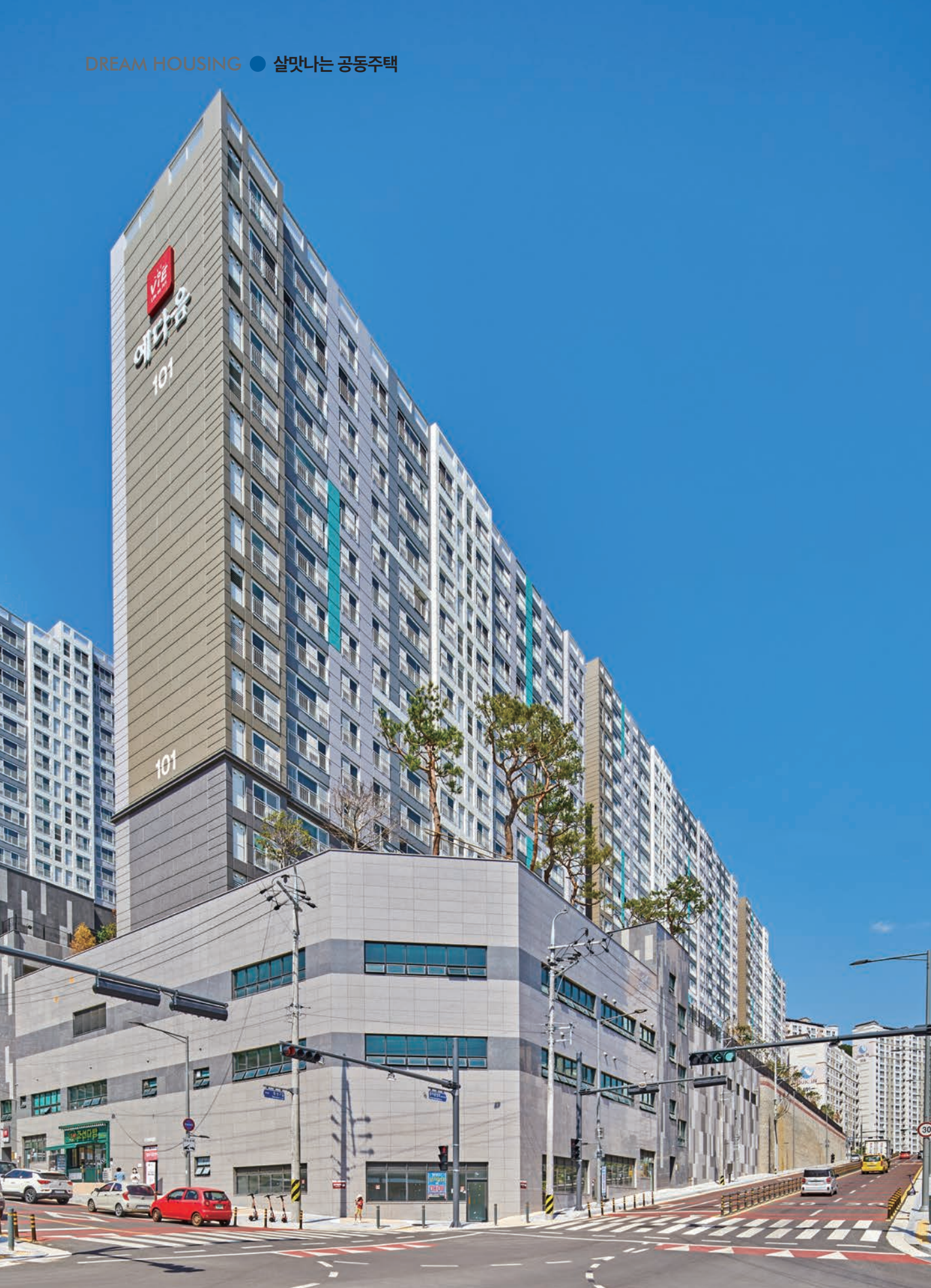
서쪽에서 바라본 단지. 동쪽으로 갈수록 높아지는 지형의 특성을 살려 지대가 낮은 서쪽 하단부에 단지상가와 커뮤니티시설, 관리사무소 등을 배치했다.
