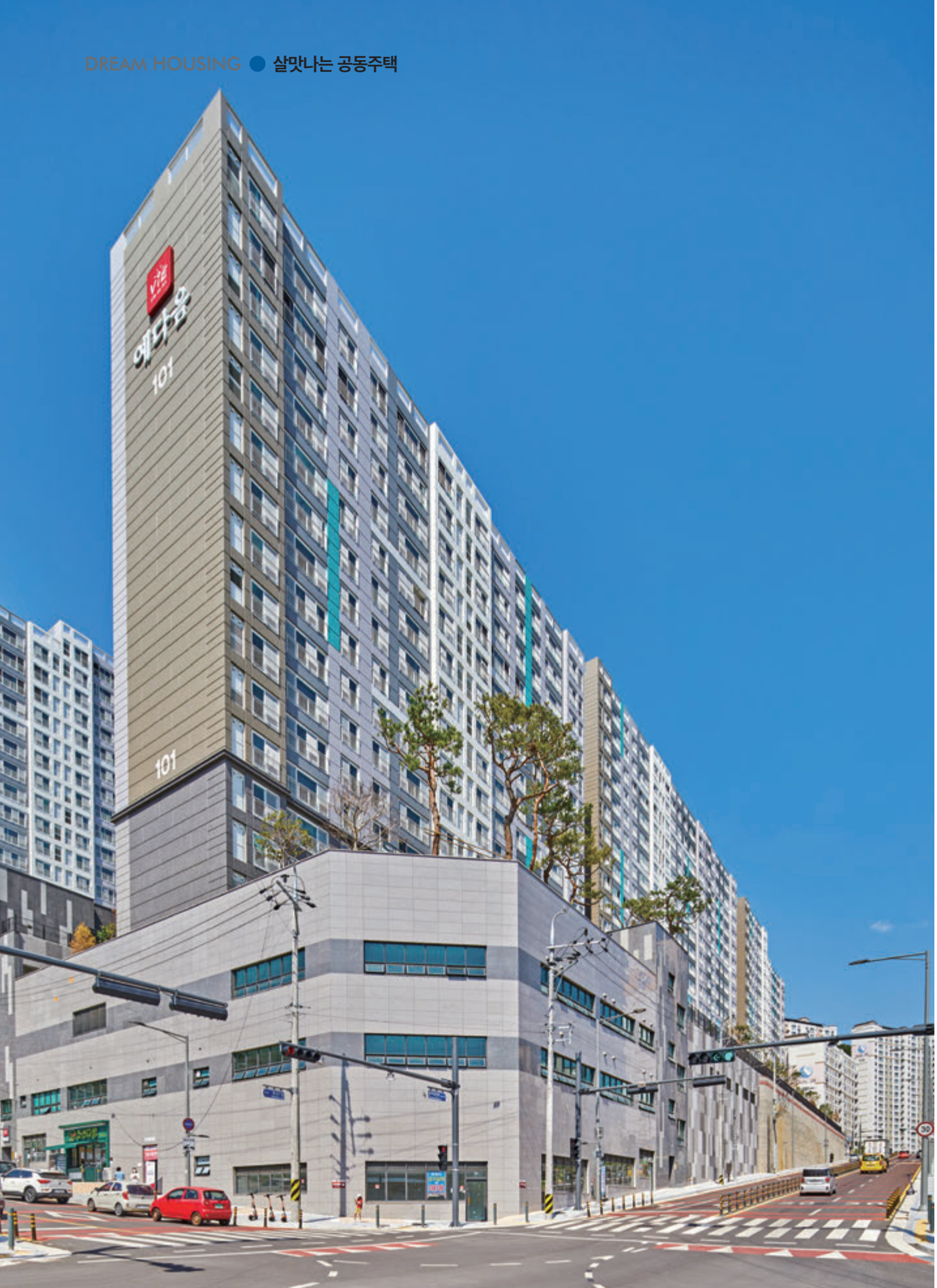
서쪽에서 바라본 단지. 동쪽으로 갈수록 높아지는 지형의 특성을 살려 지대가 낮은 서쪽 하단부에 단지상가와 커뮤니티시설, 관리사무소 등을 배치했다.
