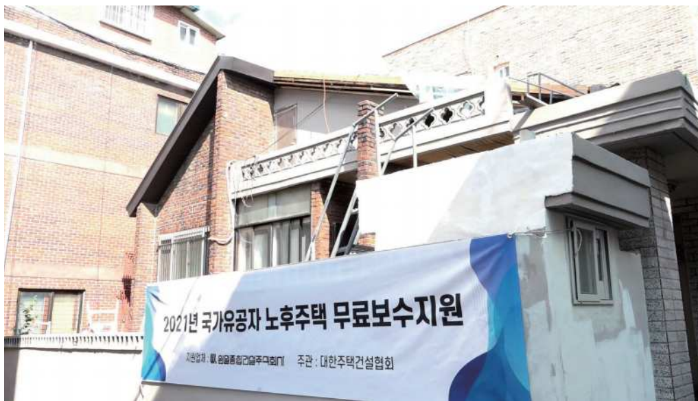
성남시에 위치한 무공수훈 유족 이정순 씨 주택 보수 현장. 원일종합건설이 4,500여 만원을 들여 공사를 완료했다.
