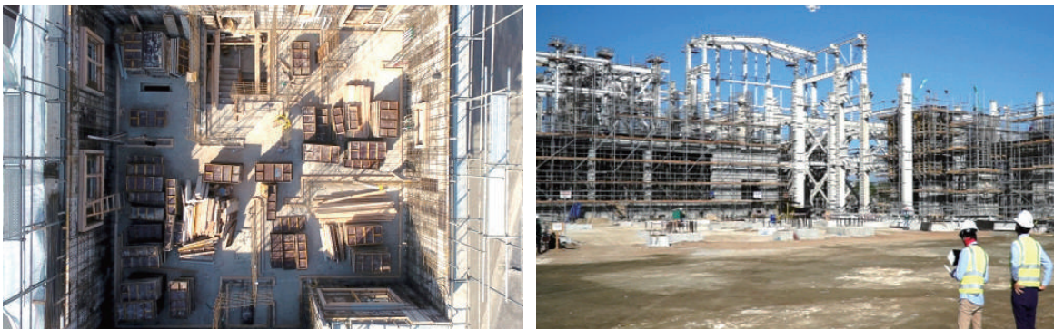
<그림3> 드론을 활용한 건설 현장 촬영 사진(좌)과 시설물 점검 장면(우)
